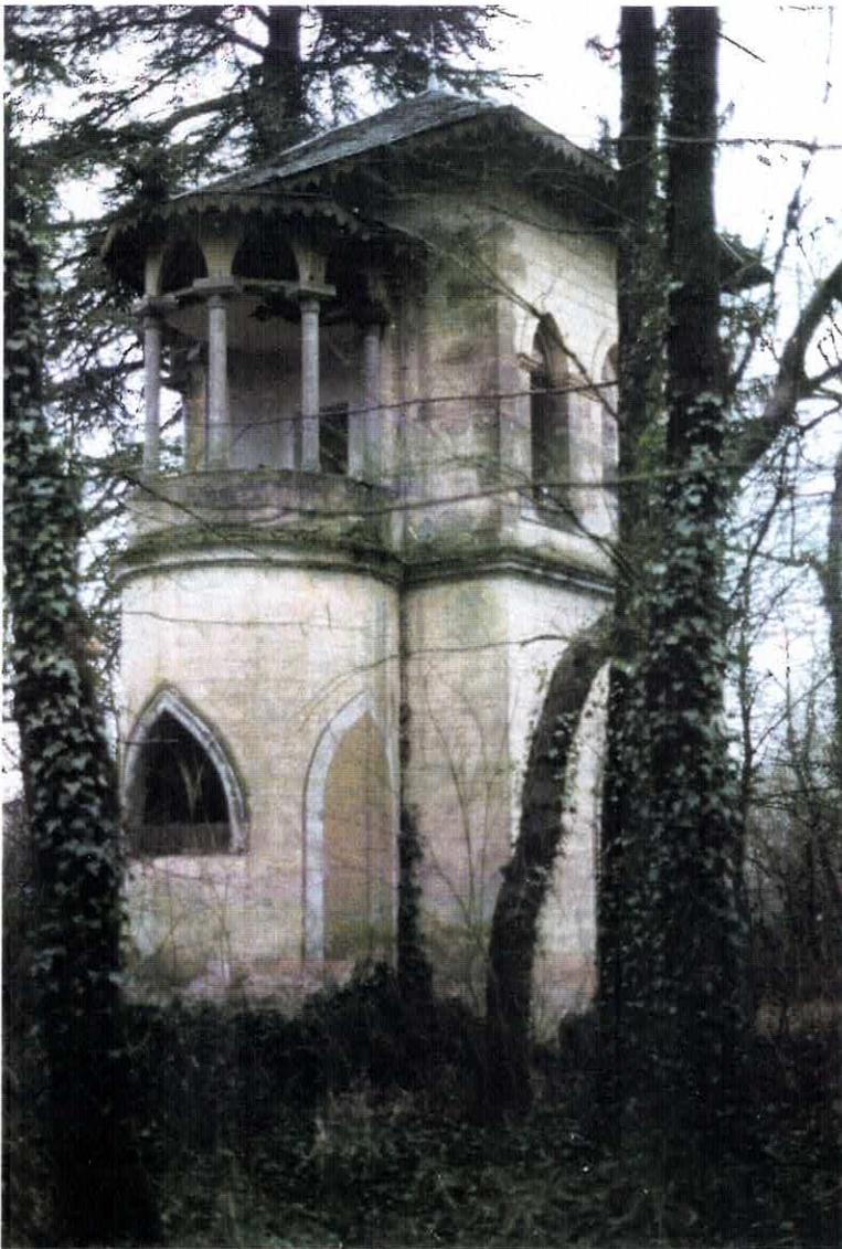
*Vue extérieure actuelle de la façade ouest et de la tourelle nord, avec l'enduit de faux appareil et de faux volets clos.*
